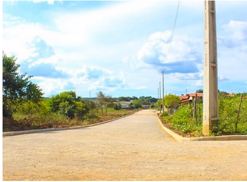
OBRAS DE CALÇAMENTO EM JATOBÁ
